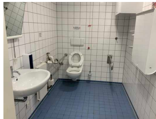
Neubau – UG: Öffentliches WC
