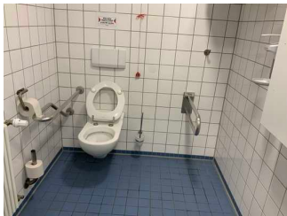
Neubau – UG: Öffentliches WC
